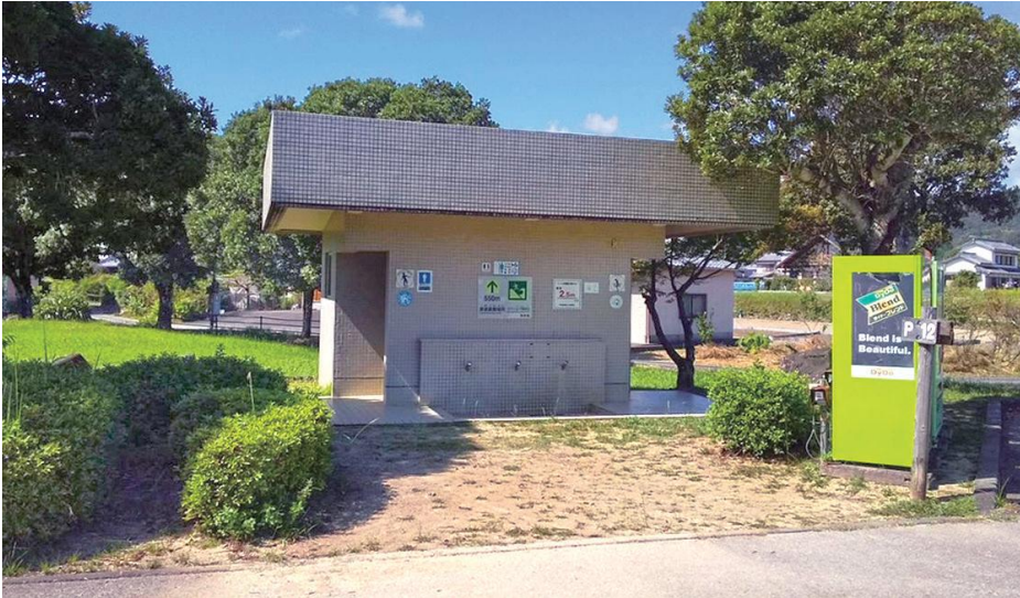
改修予定の球技場のトイレ(下田の口)
