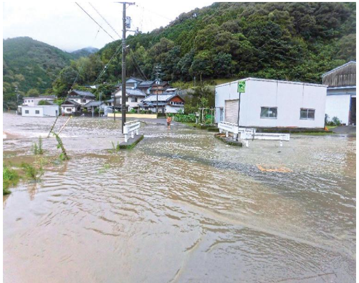
伊与木川の氾濫で孤立状態となった藤縄地区 (令和3年9月17日)
