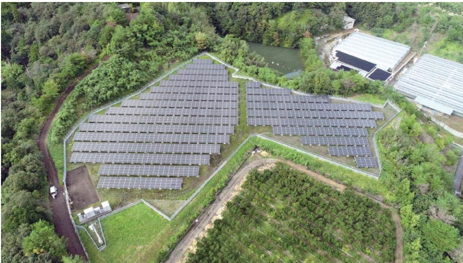
再生可能エネルギーの一つ 太陽光発電施設 (こうち・くろしお太陽光発電 (株))
