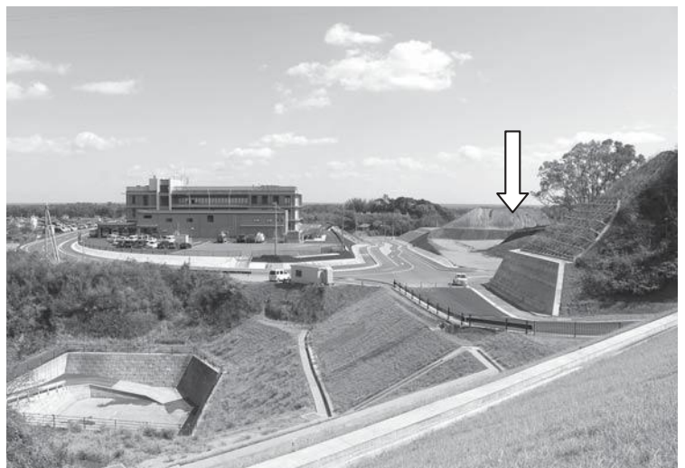
町営団地用地の造成工事が予定の新庁舎西側を山側の防災広場より望む(矢印の先)。奥側には入野地区や入野松原、海も見渡せる
