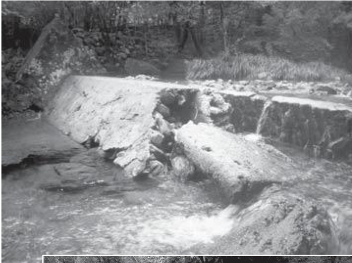
被災した市野瀬(上)と蜷川(下)の取水用堰の頭首工
