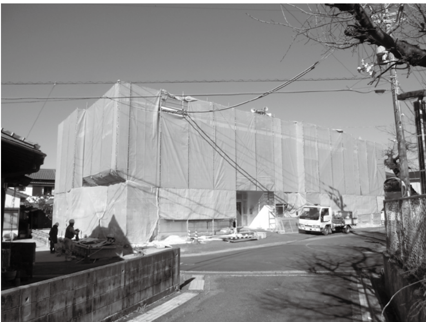
耐震工事とあわせて改修中の佐賀町民館
