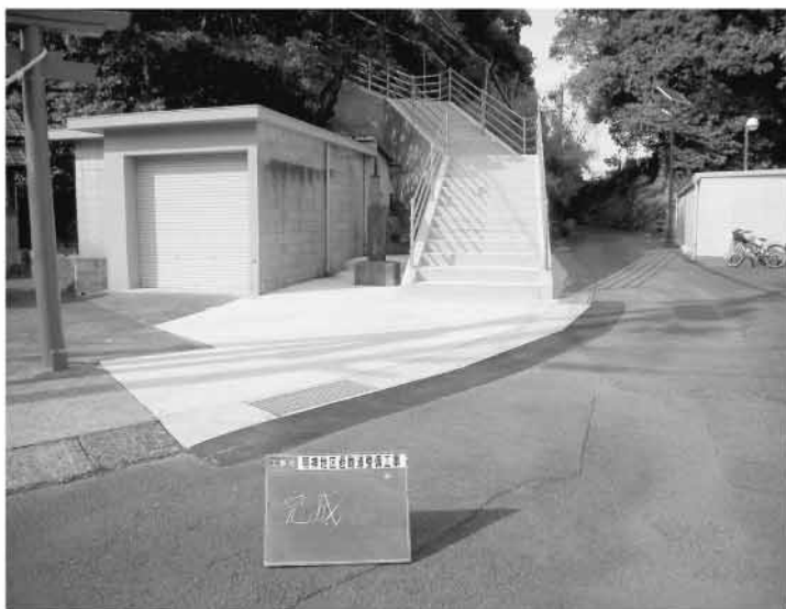
完了した佐賀明神地区の避難道整備
