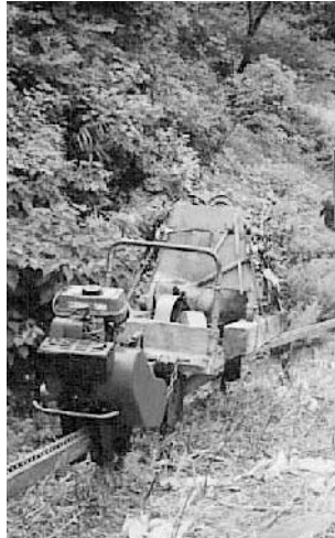
資材運搬状況(モノレール)
