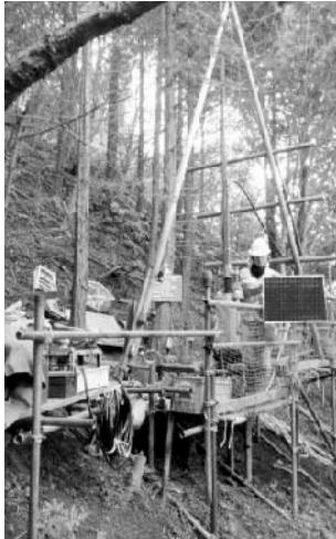
ボーリング作業状況
