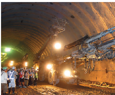
建設機械を見学する児童たち。昼夜2交代で掘削工事し、1日約4m、1カ月で約80m、開通までに約2年かかるそうです。
