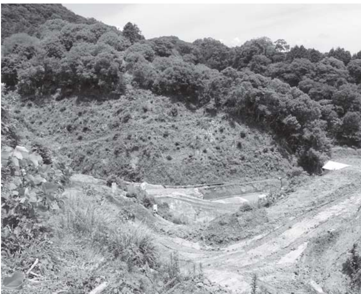
調整池工事の現況を南側より望む（7月1日）
