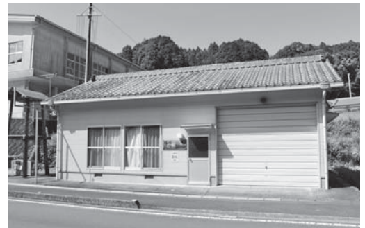
ポンプ車配備予定の蜷川コミュニティ消防センター
