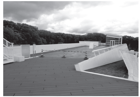
変更された大方あかつき館屋上防水(中央奥側)
