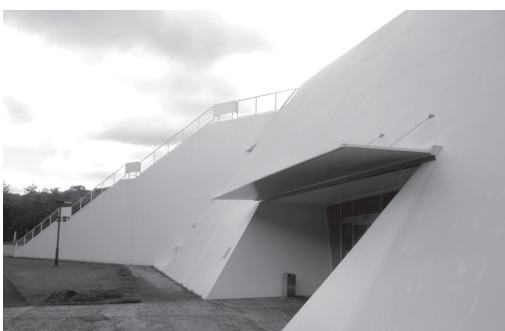
ひび割れ補修も済んだ外壁部
