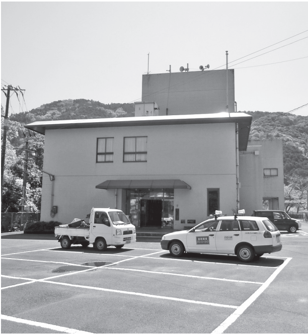
耐震補強工事予定の佐賀総合センター
