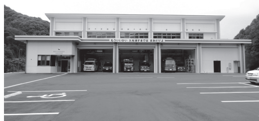
消防署を国道より望む(建物裏側にヘリポートを)
