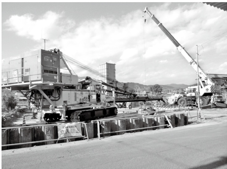
町内5ヶ所が進む避難タワーの建設工事（入野町地区）
