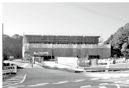
建設中の黒潮消防署
