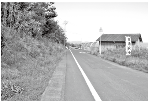
町道土橋線（三浦小学校南側）
