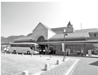
周防大島町役場（本庁舎）
