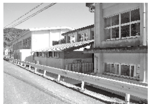
センター内の風呂場 (中央平屋)
